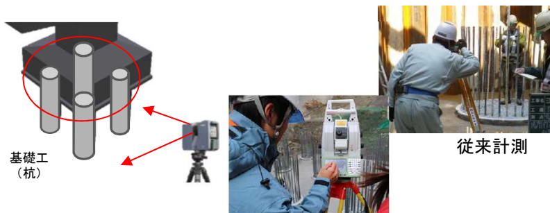
TLSを用いた場所打ち杭の出来形計測
