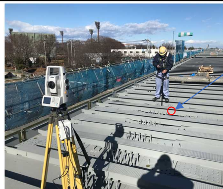
(TSを用いた計測状況写真)
