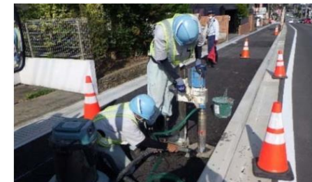
舗装版削孔工
