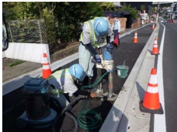
削孔作業状況
