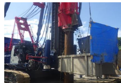
鋼管・既製コンクリート杭打工 (中掘工)
