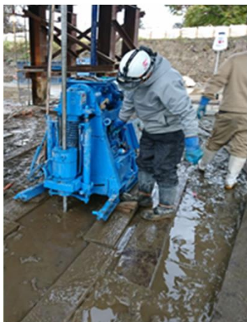
二重管ストレナーナ工法 (複相) 施工状況
