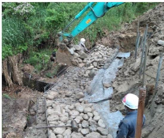
詰石作業状況
