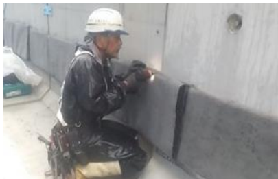
排水材設置工
