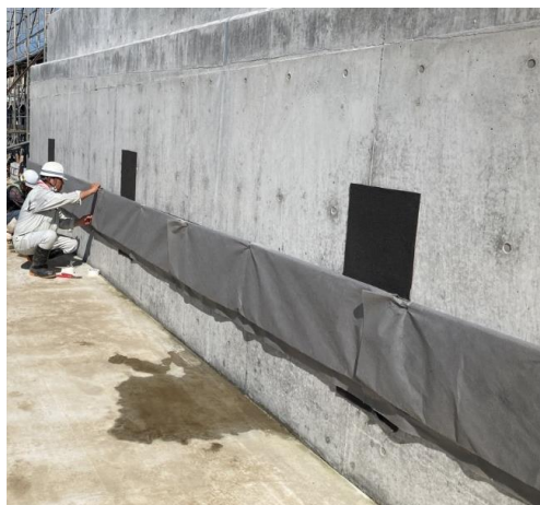
排水材設置作業状況 (接着剤)
