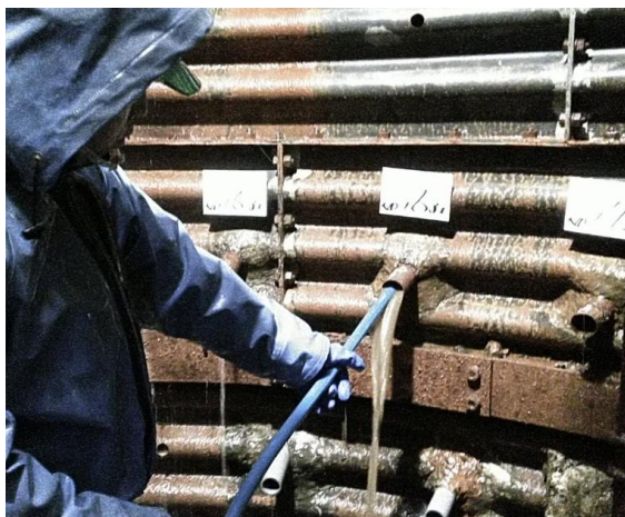
孔内洗浄作業状況(井内作業)
