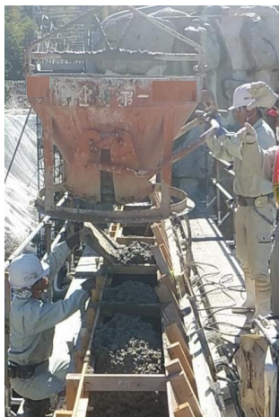
コンクリート 打設作業状況
