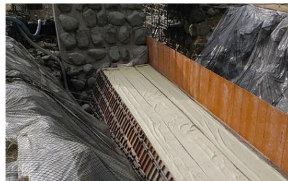
仮締切工 (砂防コンクリート締切)
