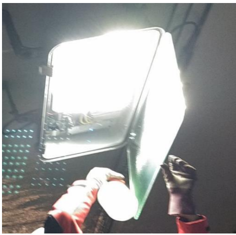
人力施工状況(内面清掃)
