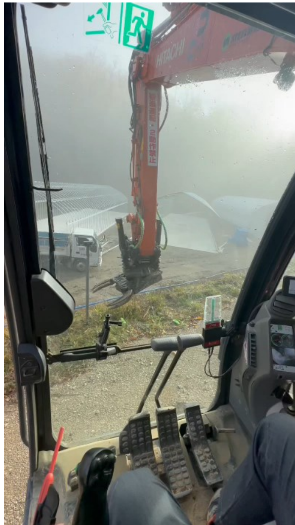
小基礎の引き抜き
