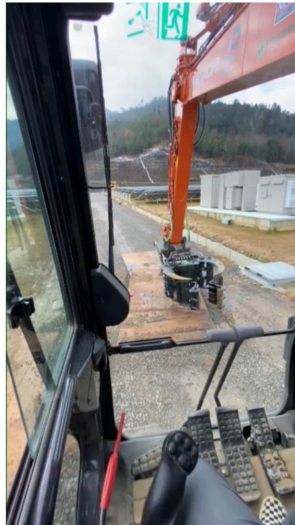
鉄板の設置・回収
