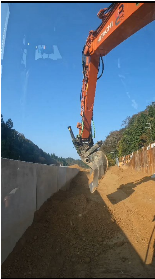
構造物際の施工
