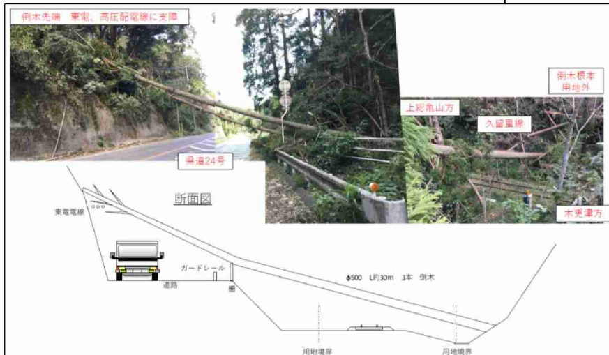
写真2 久留里線 上総松丘・上総亀山間
