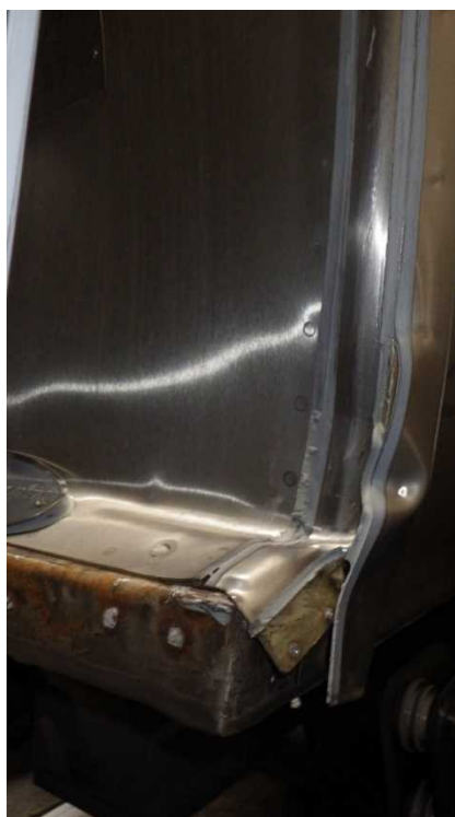
妻板の凹み (2両目新杉田駅方)
