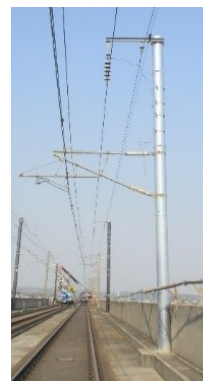
鋼管柱への交換
