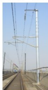
鋼管柱への交換
