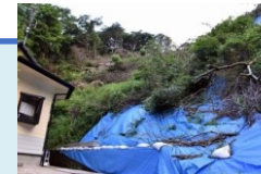
豪雨の度に 土砂崩れが多発
