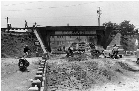
図-1 道路上への噴砂の堆積（越後線鉄橋付近）
