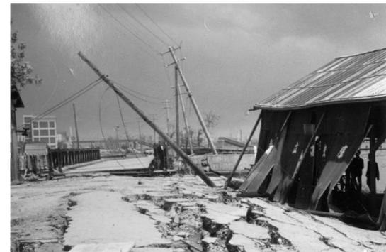
図-4 電柱の傾斜（昭和大橋右岸）
