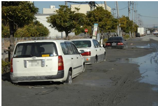
図-1 噴砂による車両の埋没（ポートアイランド）
