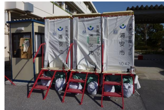
図-4 断水による仮設トイレの設置
