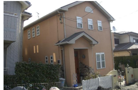
図-2 戸建て住宅の沈下・傾斜
