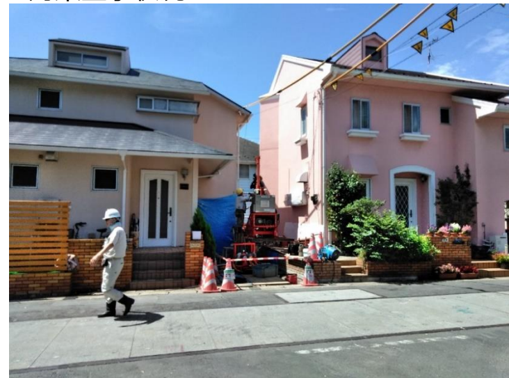
宅地-宅地間の施工
