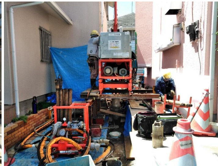
レールを敷いて施工機を移動
