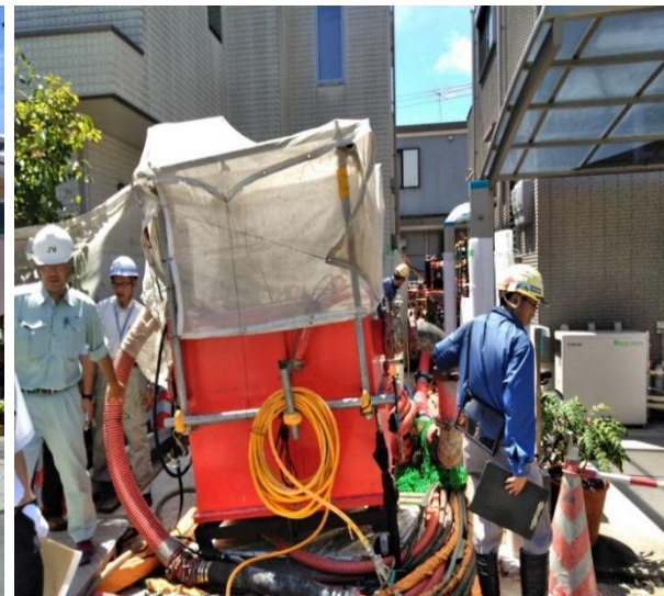
高圧噴射でセメント系固化剤を噴出
