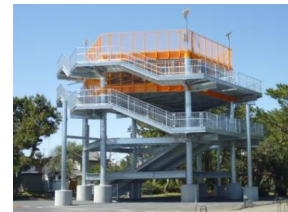
津波避難タワー
