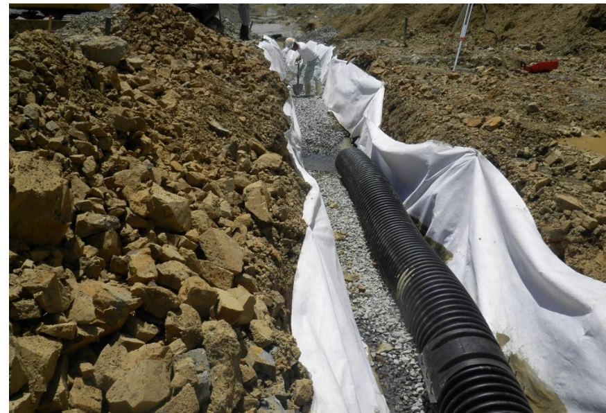
地下水を排除する排水施設の敷設（出典：UR都市機構）
