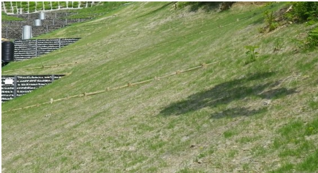
崖面以外の傾斜地への植生の導入・筋工等の措置
