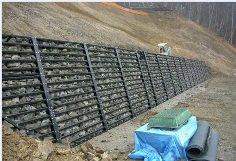
鋼製枠工
