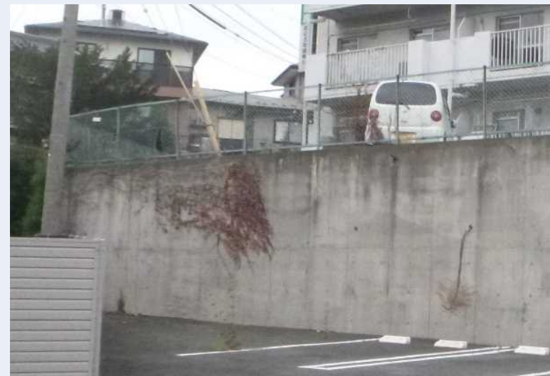
コンクリート擁壁
