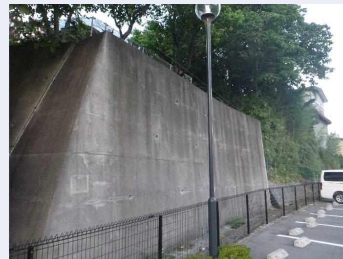
コンクリート擁壁
