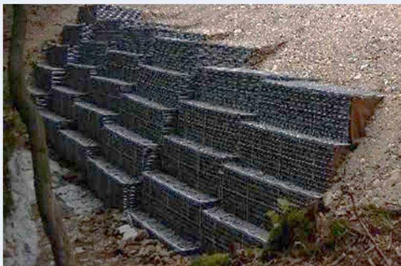
大型かご枠工
