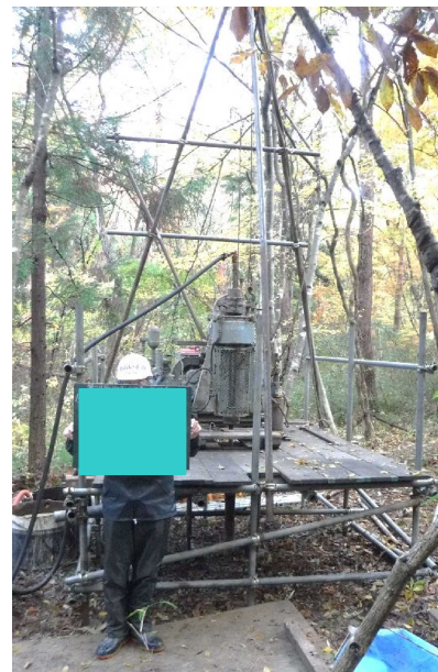
調査ボーリング
