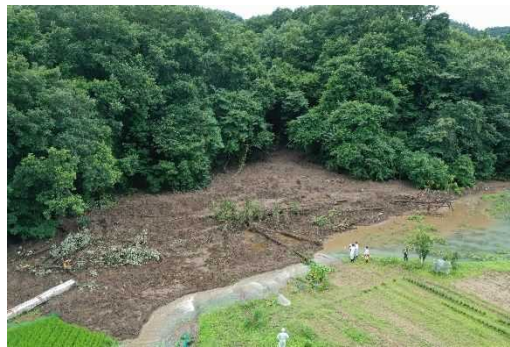
崩落後の土砂流出状況
