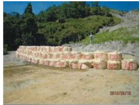
応急対策工事後（大型土嚢）
